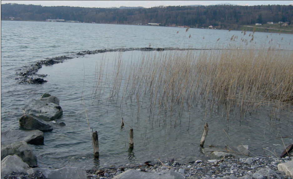
Abbildung 11: Das geschüttete Riff kurz nach der Fertigstellung. Es wurde seither durch die Wellen auf das gewünschte Niveau abgeflacht und ist vom Ufer her kaum mehr sichtbar (März 2004)
