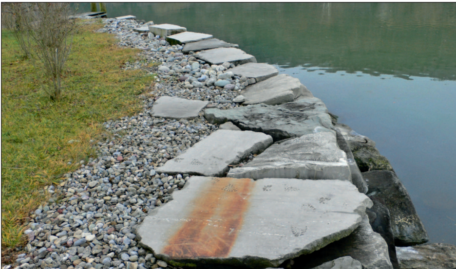
Abbildung 9: Uferbefestigung auf der südlichen Schmalseite der Insel mit Sandsteinblöcken aus dem Steinbruch Buechberg. Im Gegensatz zum ursprünglichen Feinkies hält die Nachfüllung aus Grobkies den aufpeitschenden Sturmwellen stand (Dezember 2006)
