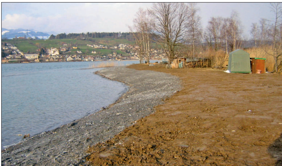
Abbildung 7: Fertiggestellte Vorschüttung auf der Westseite der Insel. Rechts, oberhalb der Uferböschung wurde das zurückgewonnene Inselgebiet auf Wunsch der Bauherrschaft humusiert (März 2004)
