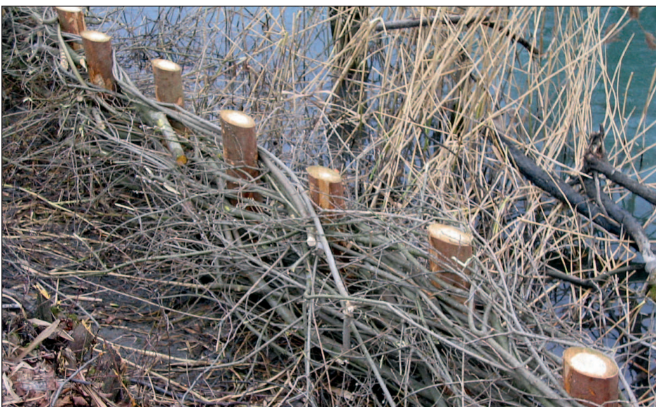
Abbildung 10: Flechtwerk auf der Ostseite der Insel, welche steil in den Baggersee abfällt (März 2004)
