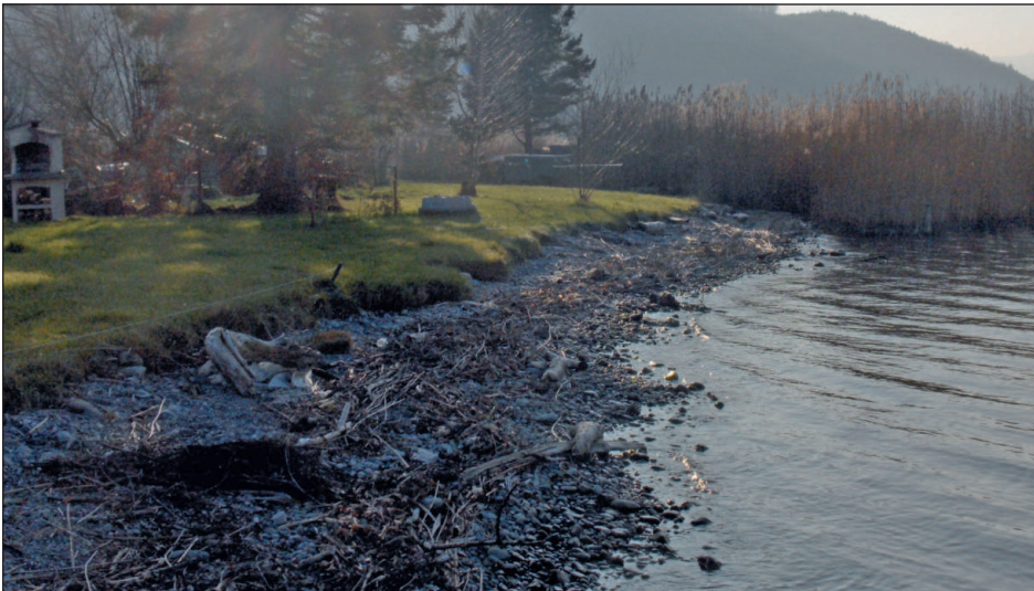
Abbildung 12: Der obere Teil der neuen Böschung wurde durch die Sturmwellen abgetragen, und es bildete sich ein kliffartiger Erosionssaum (21. Dezember 2006)
