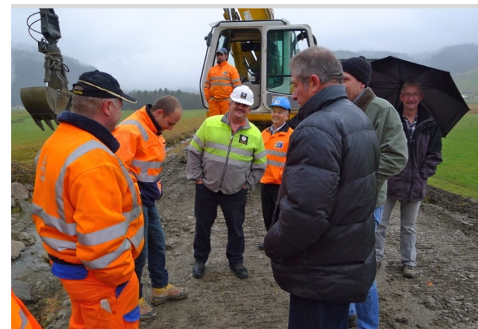
Hochwasserschutz Minster (Bausitzung)
