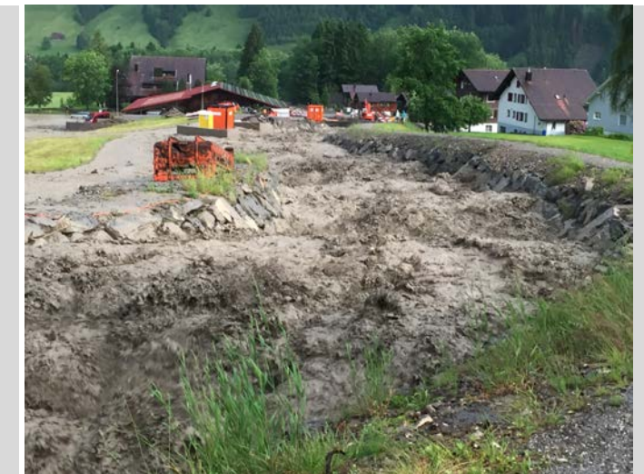
Hochwasserschutz Nidlaubach (Hochwasser 1 Woche nach Abschluss der Bauarbeiten)
