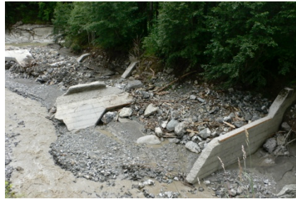
Abb. 12: Zerstörte Sperren vor dem Rückbau.
