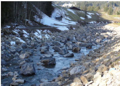
Abb. 11: Neu erstellte Blockbelegung, Ansicht bei Niederwasserabfluss.
