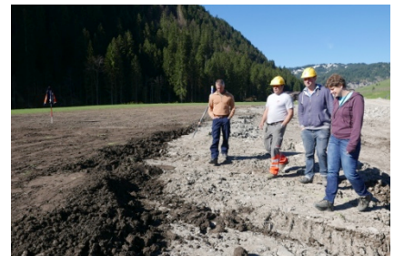
Abb. 8: Ablenkdamms (Lose 1 und 2)
