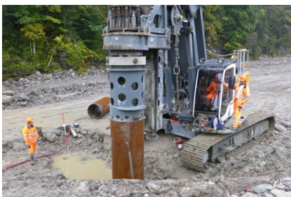
Abb. 6: Ortsbetonpfähle für Holzurückhalt (Los 2)
