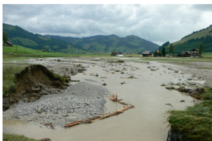
Abb. 1: Zerstörter Damm Nidlaubach
