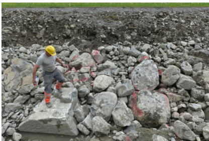
Abb. 7: Rähnenverbau (Los 2)
