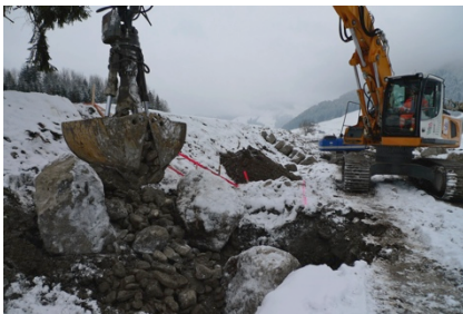
Abb. 4: Rähnenverbau (Los 1)
